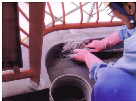
ベランダ手摺のさび止めと補修
