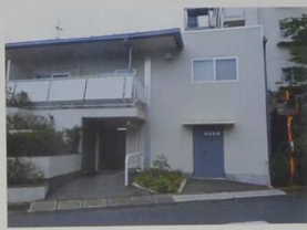
管理棟増改築工事 H23年7月 (集会室の耐震補強と防災倉庫、 トイレ、事務室、台所、和室等)
