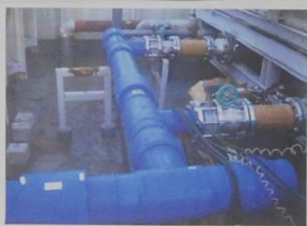
共用給水管更新工事 H22年
