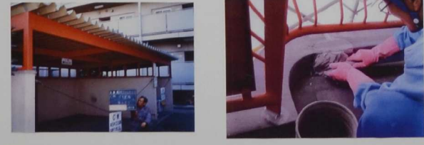
B, D棟大規模修繕工事 H6年1~7月
