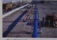
屋上配管工事
