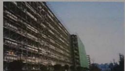
大規模修繕工事風景(シートが面白いけど寝れません)
