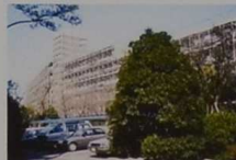
大規模修繕工事
