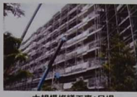
大規模修繕工事:足場
