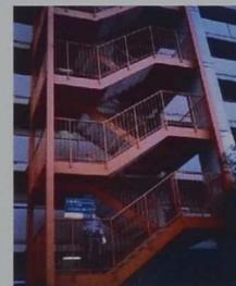
外階段の塗装工事中
