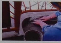
ベランダ手摺のさび止めと補修
